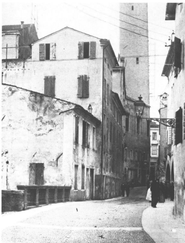
Fig. 22. Contrada delle Beccherie (via Cesare Battisti dal 1916) dal ponte Falaroto (detto delle Beccherie) prima della demolizione dell'isolato per la costruzione della nuova ala del Bo' (1915-22).
