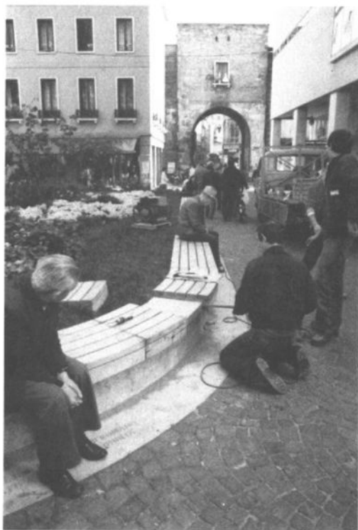
Fig. 47. Alla base della nuova aiola di separazione tra pedoni e veicoli è segnalato in superficie il tracciato della via romana.
