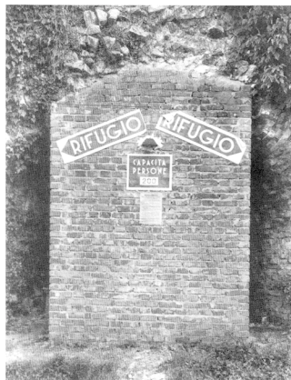
Utilizzo difensivo delle Mura: l'ingresso del rifugio antiaereo alle Casematte di S. Massimo.
